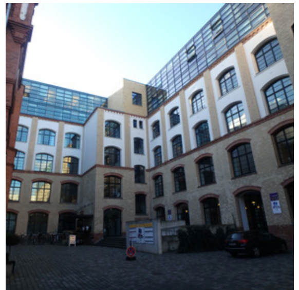
Umbaumaßnahmen innerhalb eines Gebäudekomplexes
