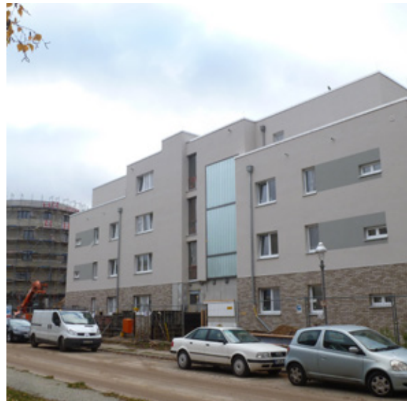
Neubau einer Wohnanlage mit Tiefgarage
