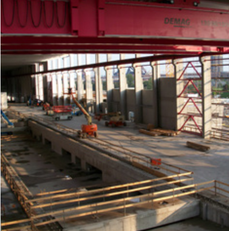
Blick in die Haupthalle während der Rohbauarbeiten
