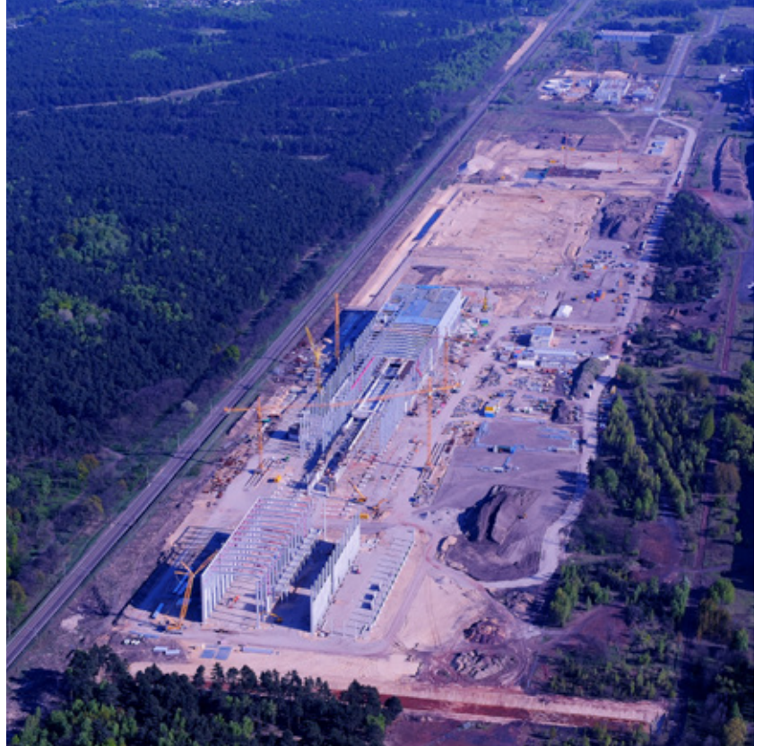
Luftaufnahme der gesamten Baustelle des Papierfabrik-Komplexes mit dem Zentrum des Hauptgebäudes
