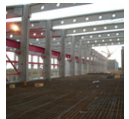
Rahmenkonstruktion, Kranbahnen, Zwischendecken (Rohbauphase)
