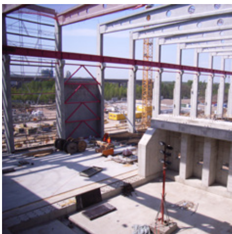
Tragkonstruktion inklusive Maschinenstuhl der Fertigungshalle
