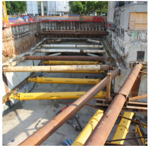
Überblick Baugrube mit Aussteifungskonstruktion
