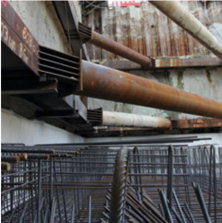
Eckaussteifungskonstruktion und Bodenplattenbewehrung
