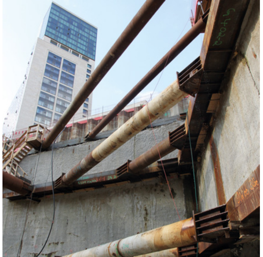
Baugrube Riegelgebäude mit Hochhaus „Zooenster“ im Hintergrund
