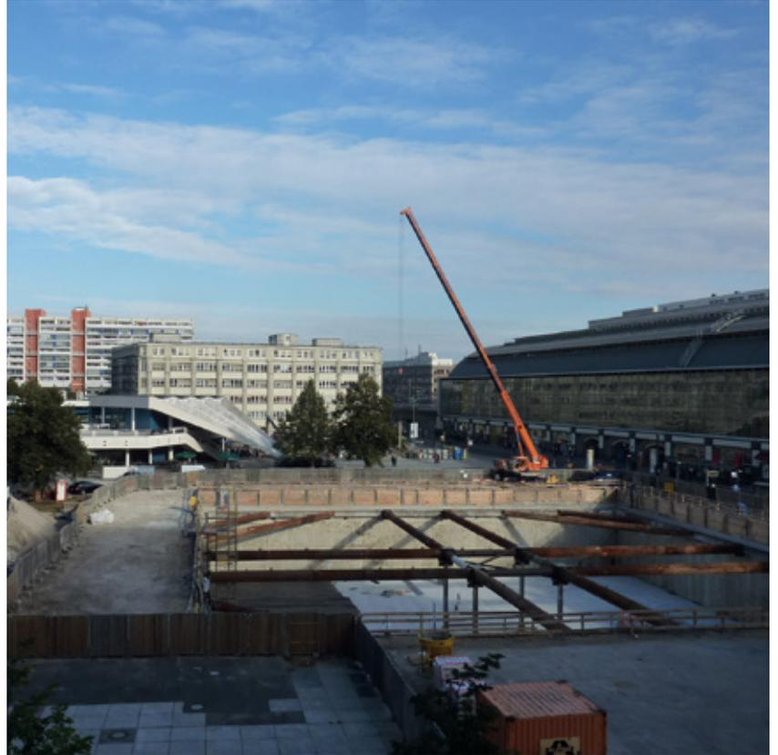
Die horizontale Abdichtung der Baugrube wurde durch eine in ca. 18 m Tiefe liegende Hochdruckinjektionssole, in einer Stärke von ca. 1 m, ausgeführt. Da eine Rückverankerung der Baugrube wegen der o. g. Randbedingungen ausgeschlossen war, wurde die Ortbetonschlitzwand einlagig mit vorgespannten DN 900 mm Horizontalsteifen gesichert, welche in der Mitte der Baugrube durch vier Knicksicherungen unterstützt wurden.
