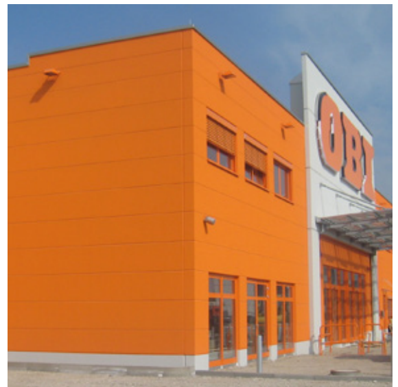
Abb. 1: Bauteil A auf dem südwestlichen Grundstücksbereich
