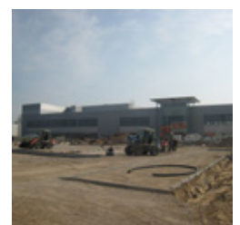
Abb. 3: Bauarbeiten auf dem Bau-grundstück
