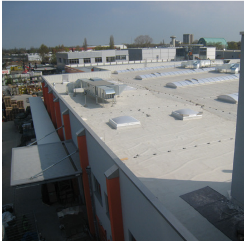
Abb. 4: Blick auf die beschriebene Dachkonstruktion
