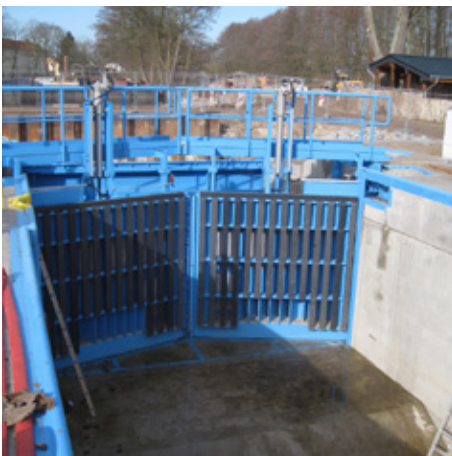
Schleusentor am Oberhaupt
