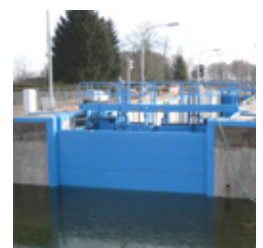
Mit Dammtafeln verschlossenes Oberhaupt
