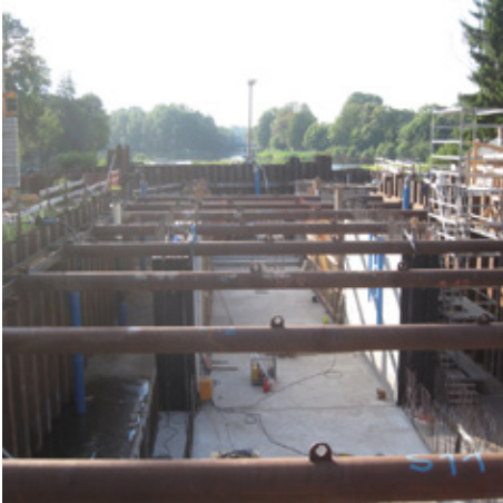
Baugrubenverbau, Bodenplatte mit Segmenten der Kammerwände
