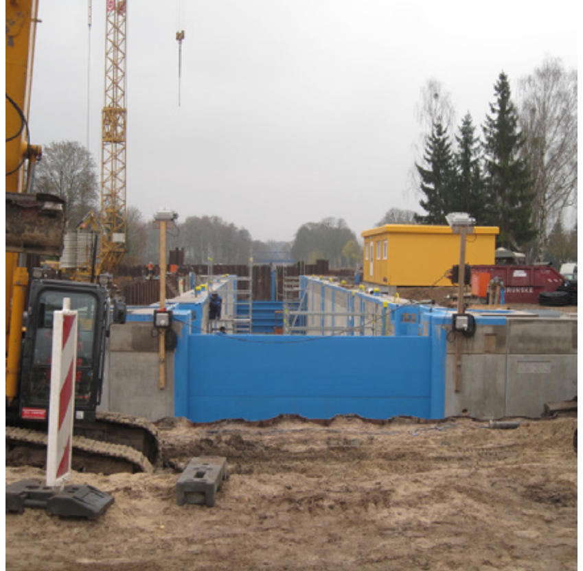
Mit Dammtafeln abgedichtete, fertig gestellte Schleusenammer
