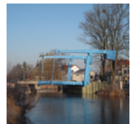
Fertig gestellte Klappbrücke
