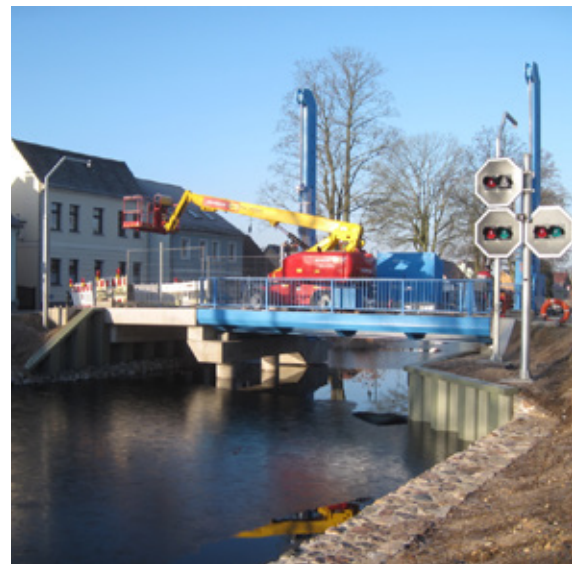
fertig gestellte Hubbrücke
