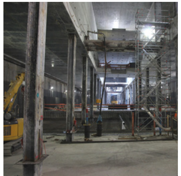
Rohbau Bahnhof UDL, Ebene U5 mit Primärstützen vor Herstellung der Bodenplatte
