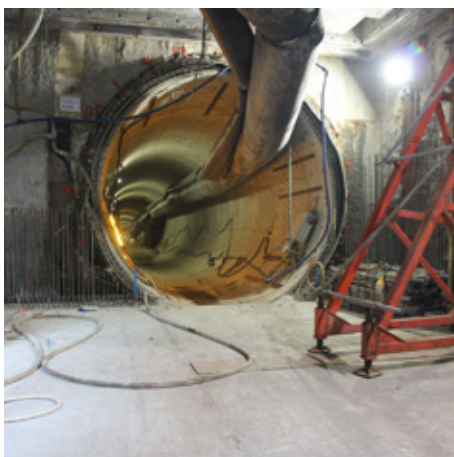
U5 – Blick in nördliche Tunnelröhre
