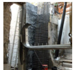
U6 – Anschluss an den bestehenden Tunnel
