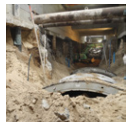
U5 – Aushub bzw. Abbruch Ebene 3
