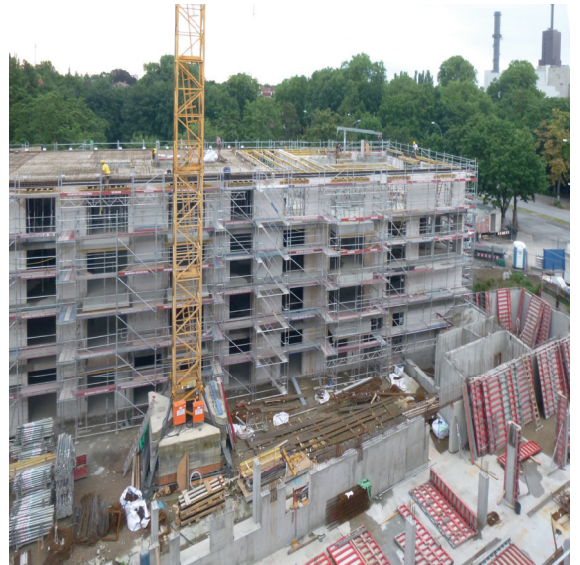
Blick auf die Baustelle
