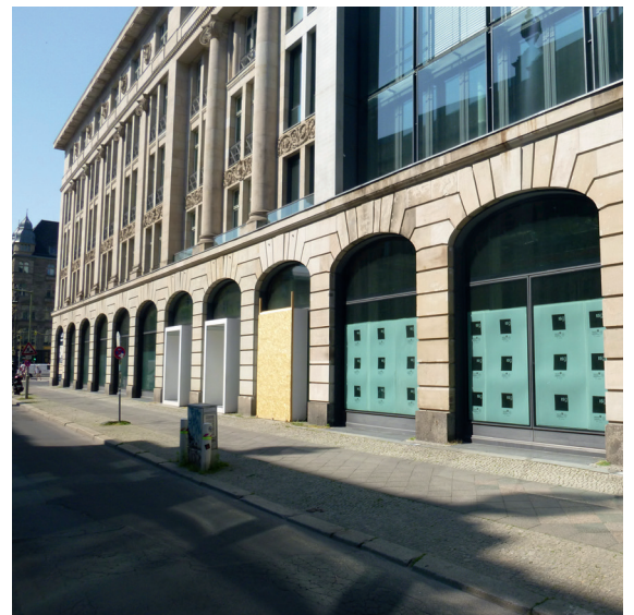
Blick auf das Bestandsgebäude
