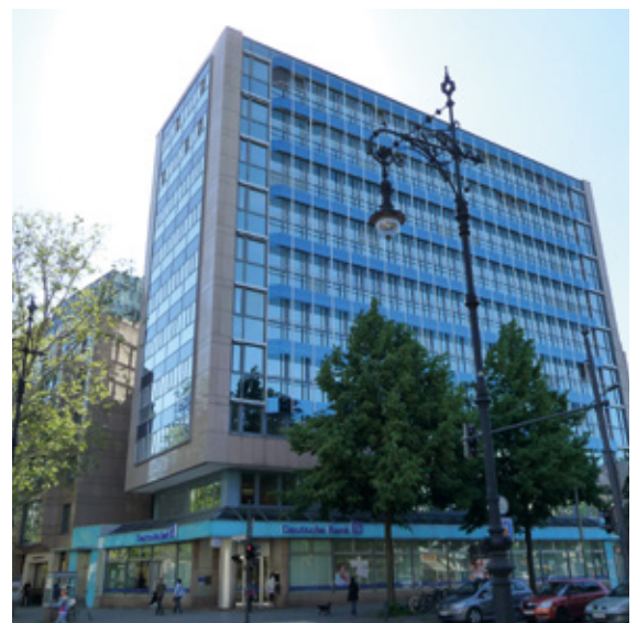
Abb. 1.: Fassade nach der Giebelöffnung
