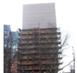
Abb. 3.: Giebelfassade während der Bauphase
