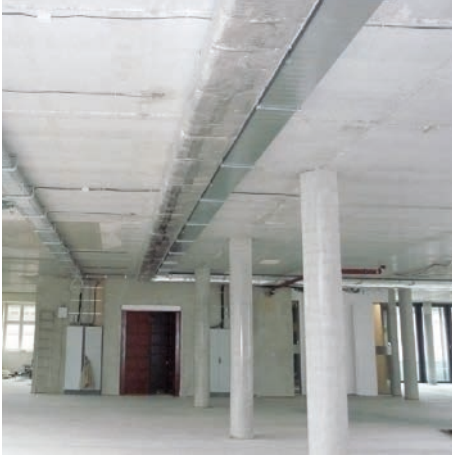
Bestandssituation: leere Büroeinheit
