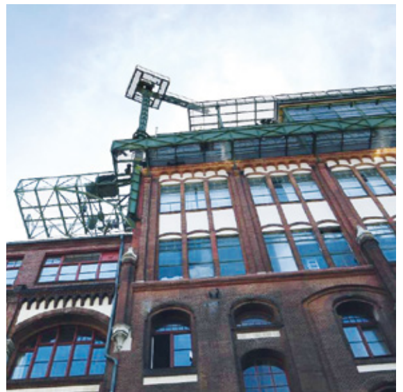
Erarbeitung ganzheitlicher Brandschutzkonzepte für diverse Umbauten in den Goerz-Höfen
