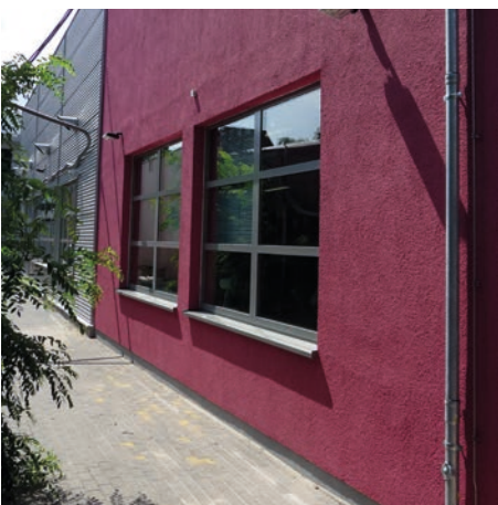
Abb. 5: Anbau Schmiedepresse außen
