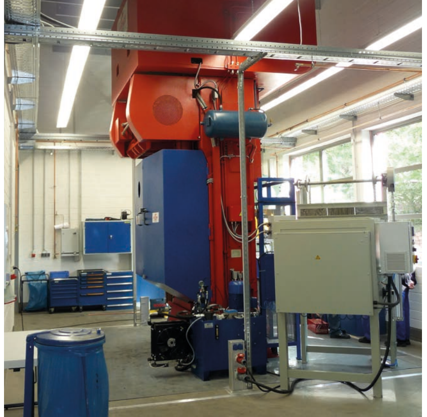
Abb. 6: Anbau Schmiedepresse innen
