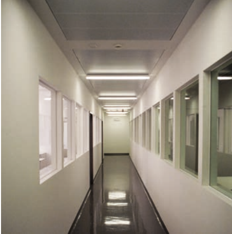
Abb. 2: Flurbereich mit Brandschutzverglasung
