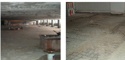
Parkdeck während der Sanierung
