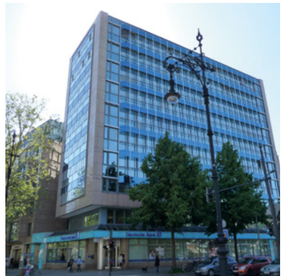
Fassade nach der Giebelöffnung
