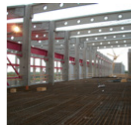
Rahmenkonstruktion, Kranbahnen, Zwischendecken (Rohbauphase)
