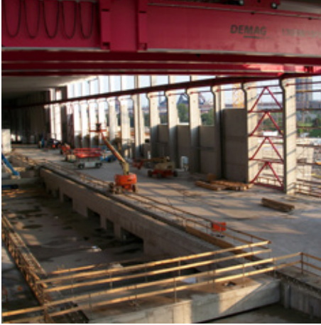
Blick in die Haupthalle während der Rohbauarbeiten
