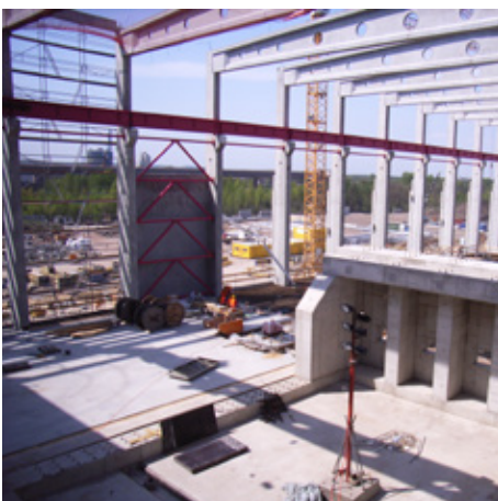
Tragkonstruktion inklusive Maschinenstuhl der Fertigungshalle
