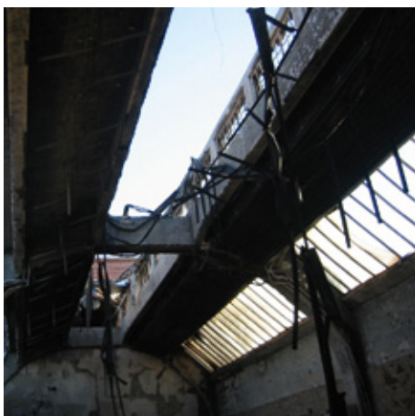
Decke der Verkaufshalle
