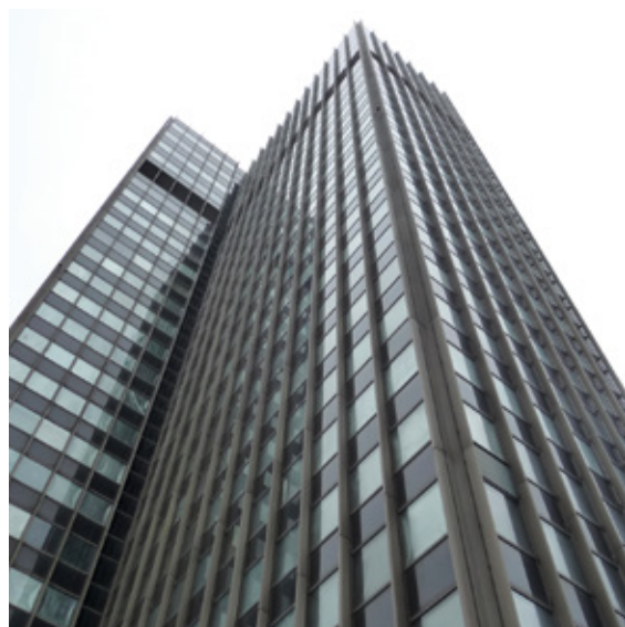
Brandschutzbeauftragter nach vfdb 12-09/01: 2009-03 (02) für die Schadstoffsanierung des Hochhausturmes
