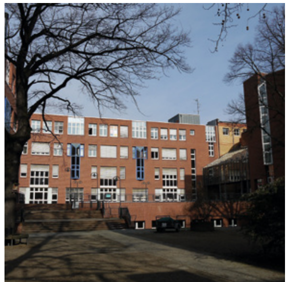
Hofseitige Ansicht der Gebäudeteile an der Quitzowstraße
