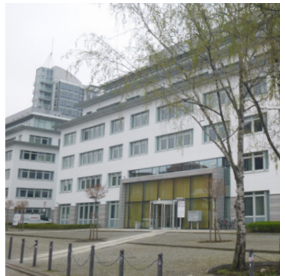
Eingangsbereich Karree 1 (Foto © FEUERSCHILD BRANDSCHUTZ GmbH)
