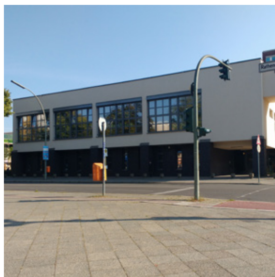
Straßenansicht „Heinrich-Zille-Haus“ © Max Kaminski
