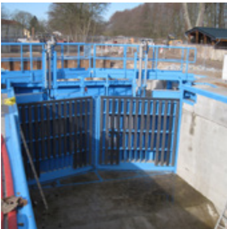
Schleusentor am Oberhaupt
