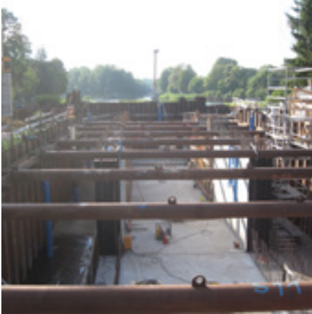
Baugrubenverbau, Bodenplatte mit Segmenten der Kammerwände
