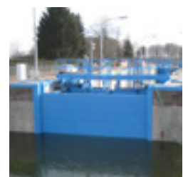
Mit Dammtafeln verschlossenes Oberhaupt
