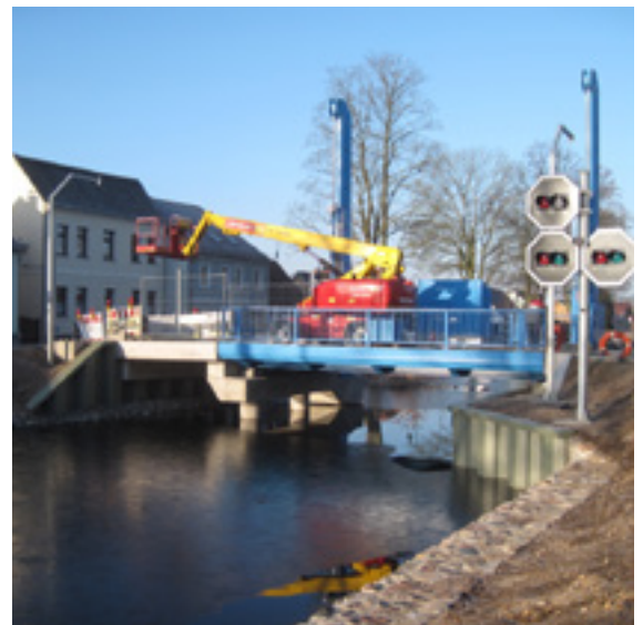
fertig gestellte Hubbrücke
