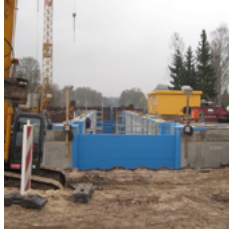
Mit Dammtafeln abgedichtete, fertig gestellte Schleusenammer
