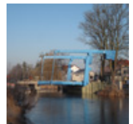
fertig gestellte Klappbrücke
