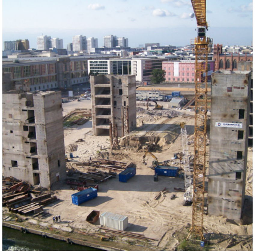
Ansicht während des Rückbaus
