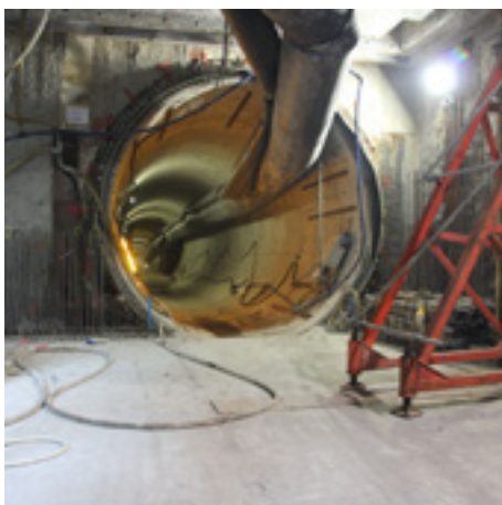
U5 - Blick in nördliche Tunnelröhre
