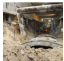
U5 - Aushub bzw. Abbruch Ebene -3
