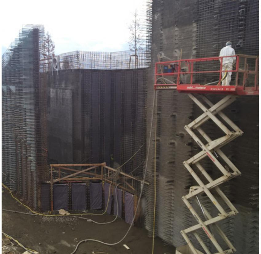
Erste Spritzbetonlage an der Kletterwand
