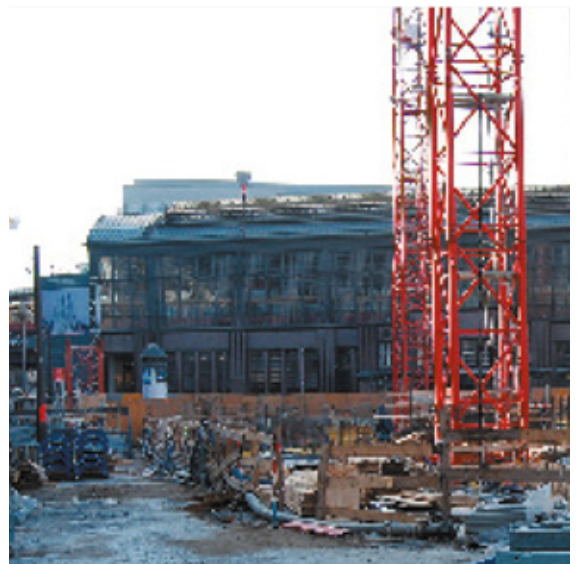
Baustellenübersichtsfoto nach Fertigstellung der Untergeschosse im Rohbau, Stadtbahnhof Friedrichstraße
