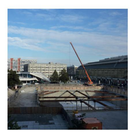
Die horizontale Abdichtung der Baugrube wurde durch eine in ca. 18 m Tiefe liegende Hochdruckinjektionssohle, in einer Stärke von ca. 1 m, ausgeführt. Da eine Rückverankerung der Baugrube wegen der o. g. Randbedingungen ausgeschlossen war, wurde die Ortbetonschlitzwand einlagig mit vorgespannten DN 900 mm Horizontalsteifen gesichert, welche in der Mitte der Baugrube durch vier Knicksicherungen unterstützt wurden.
