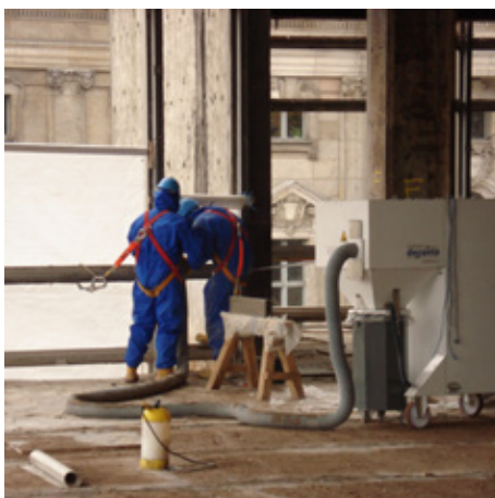
Vorbereitende Arbeiten zur Asbestsanierung
