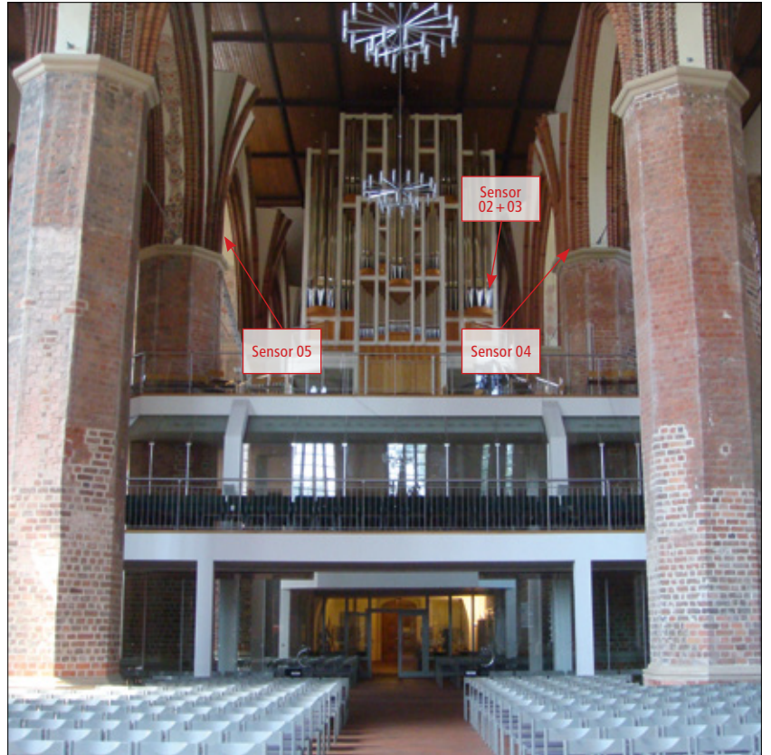
Sensoren 04 und 05 an den Pfeilerköpfen, Sensoren 02 und 03 an der Tragkonstruktion der Orgel (einaxial)
